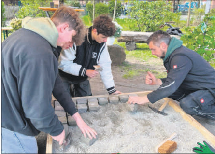
Das Verlegen von Steinen ausprobieren.
